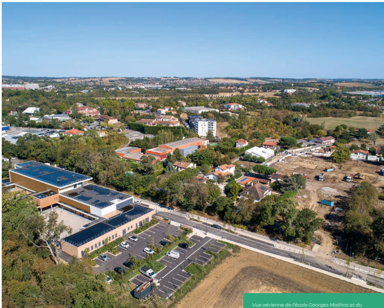
Vue aérienne de l'école Georges Mailhos et du projet immobilier dit "E09-E10" en cours de chantier.
